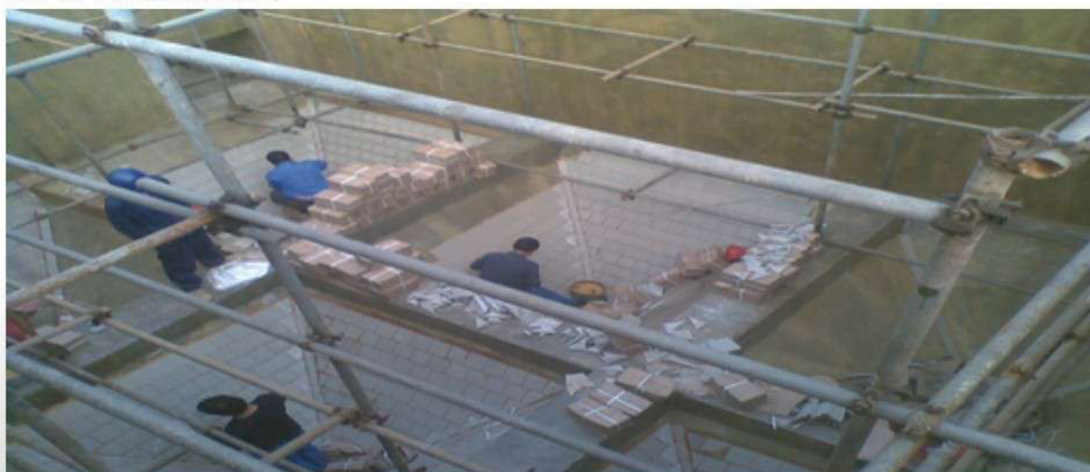
55kt/a中和氧化槽衬砖防腐阶段
