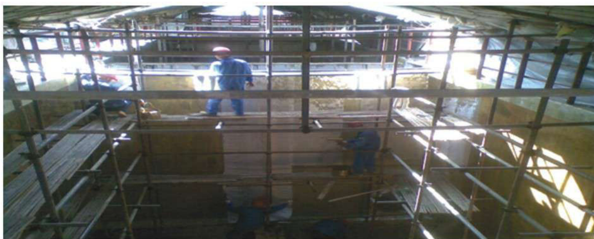
55kt/a中和氧化槽FRP防腐阶段
