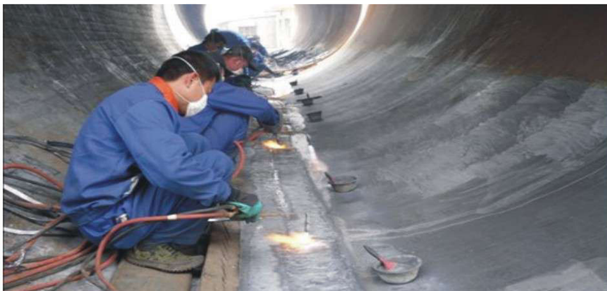
100Kt/a电锌氧压浸出高压反应釜施工现场
